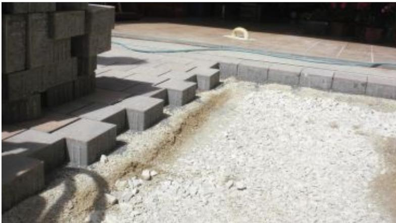
Pflaster wird auf einer Bettungsschicht und einer Tragschicht verlegt, damit es keine nachträglichen Setzungen gibt.
