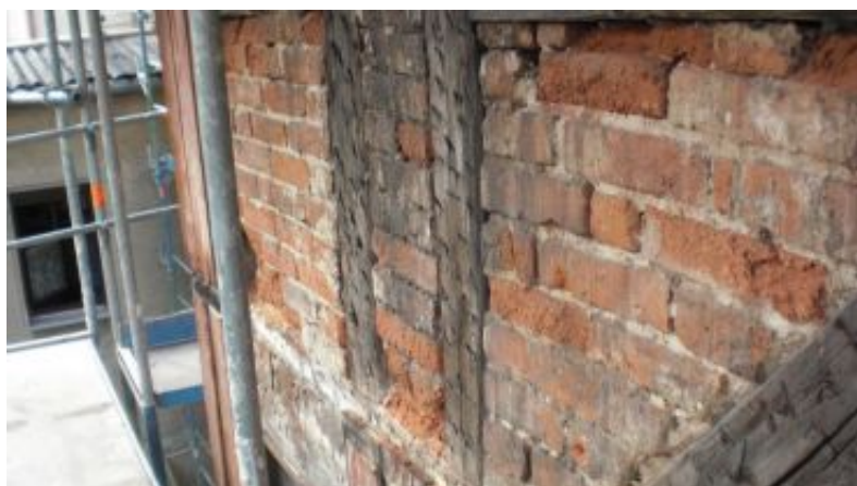
Sichtmauerwerk an denkmalgeschützten Fassaden ist möglichst detailgetreu zu ergänzen.
