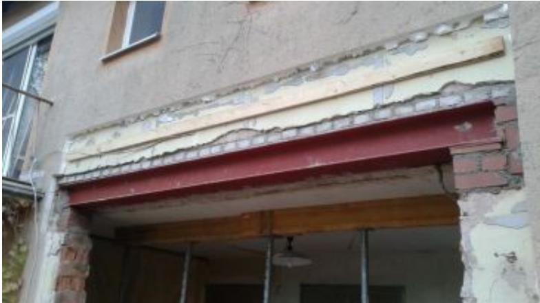
Für diese Außenwand ist ein Stahlträger als statische Ersatzmaßnahme eingebaut worden. Anschließend kann er optisch mit einer Verkleidung aus Putz oder Trockenbau ummantelt werden.
